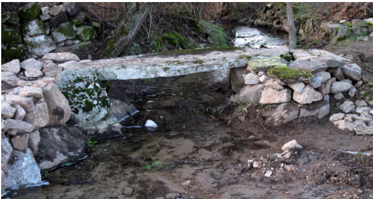
Puente de El Arroyo sobre el río Milón
