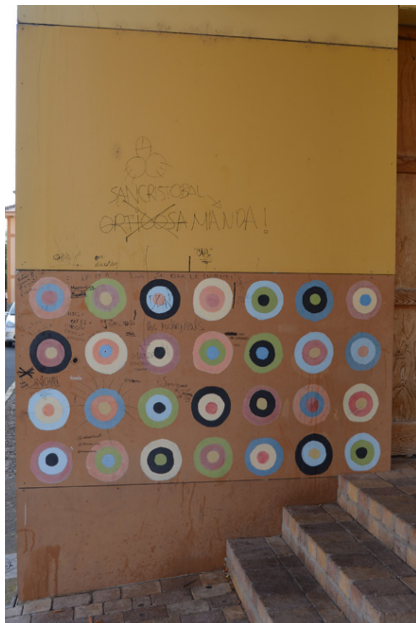
Detalle de la fachada oeste de La Casa Joven
